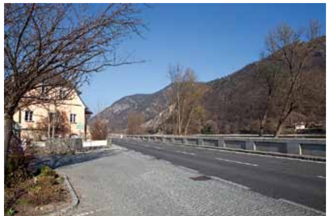
Abb. 4.2: Wösendorf nach Straßenbau und Hochwasserschutz
