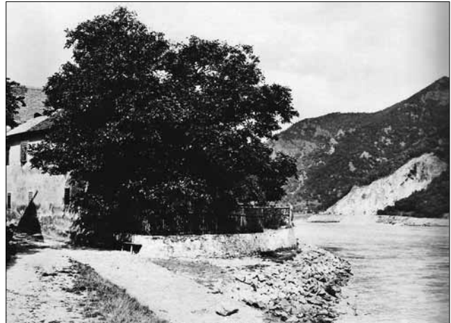
Abb. 4.1: Wösendorf vor Straßenbau und Hochwasserschutz
