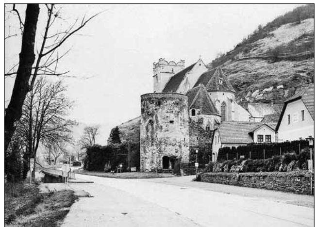
Abb. 3.2: St. Michael nach dem Straßenbau
