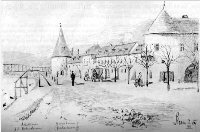
Abb. 2: Stein an der Donau, Donaulände mit Schablone für den Bahndamm, Zeichnung von Rudolf Pichler
